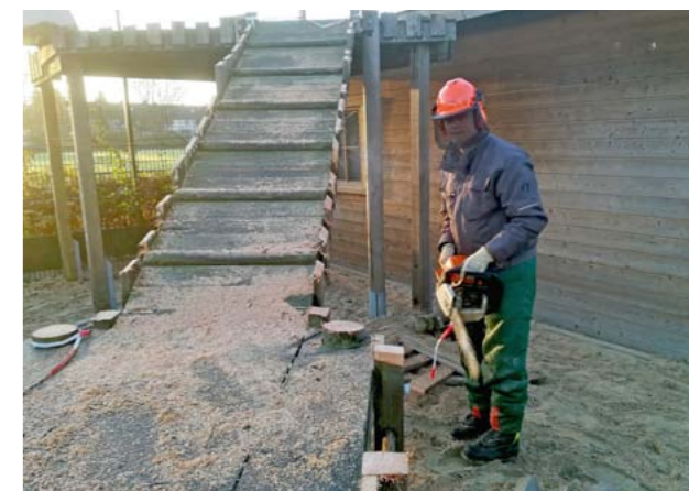
Marcus Stillwell zieht mit dem Trecker die Palisaden aus der Erde. Matthias Wiehe bedient die Kettensäge.
